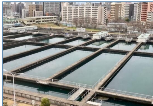
ぎょうしゅうちんでんち 凝集沈澱池
